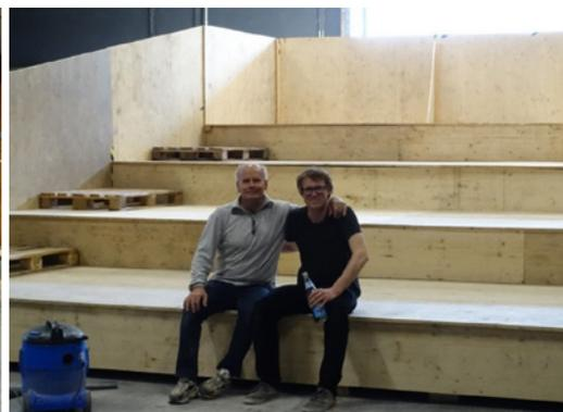
Der Umbau 2022 ist seit längerem in Gange. Bereits im April wurden im Rahmen des Nussknackprojektes die Zuschauertribüne fertiggestellt. Dazu zählte die statische Verstärkung und das Anbringen von seitlichen Geländern zur Absturzsicherung. Ebenso wurde ein Türrdurchgang verschlossen, was aus brandschutzrechtlicher Sicht notwendig war.
